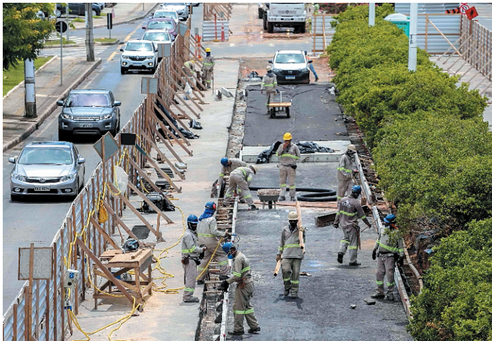
Avenida ACM, na região do Itaigara, em obras
